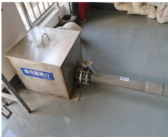
污水处理站排口
