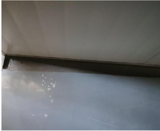
危废库内部导流槽
