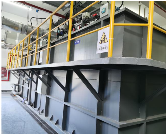
污水处理站整体结构
