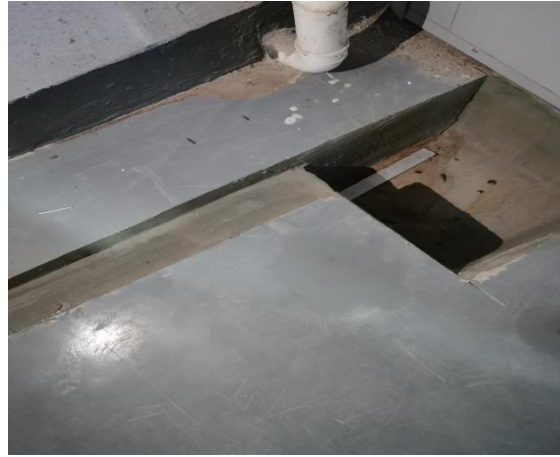
危废库内部收集池
