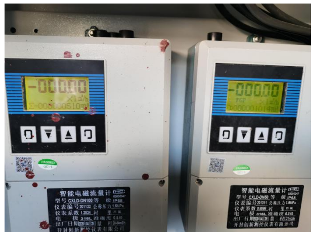
污水处理站流量计
