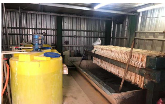
图 4-1.2 废水治理设施图
