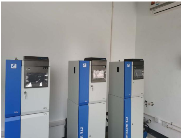
污水处理站在线监测仪器
