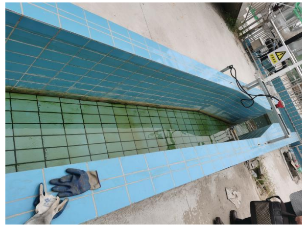
污水处理站排口
