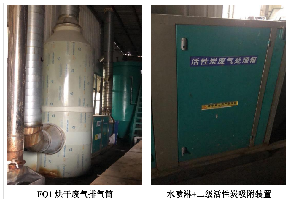
附图 4.1-4 废气治理设施图
