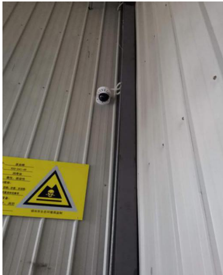
危险废物贮存设施视频监控
