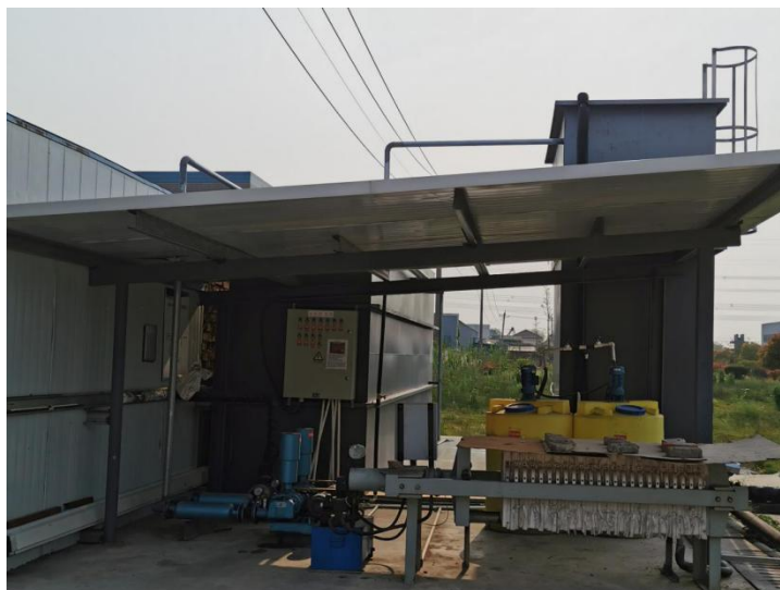
附图 4.1-2 污水处理装置
