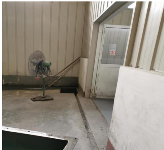
导流沟和集水坑
